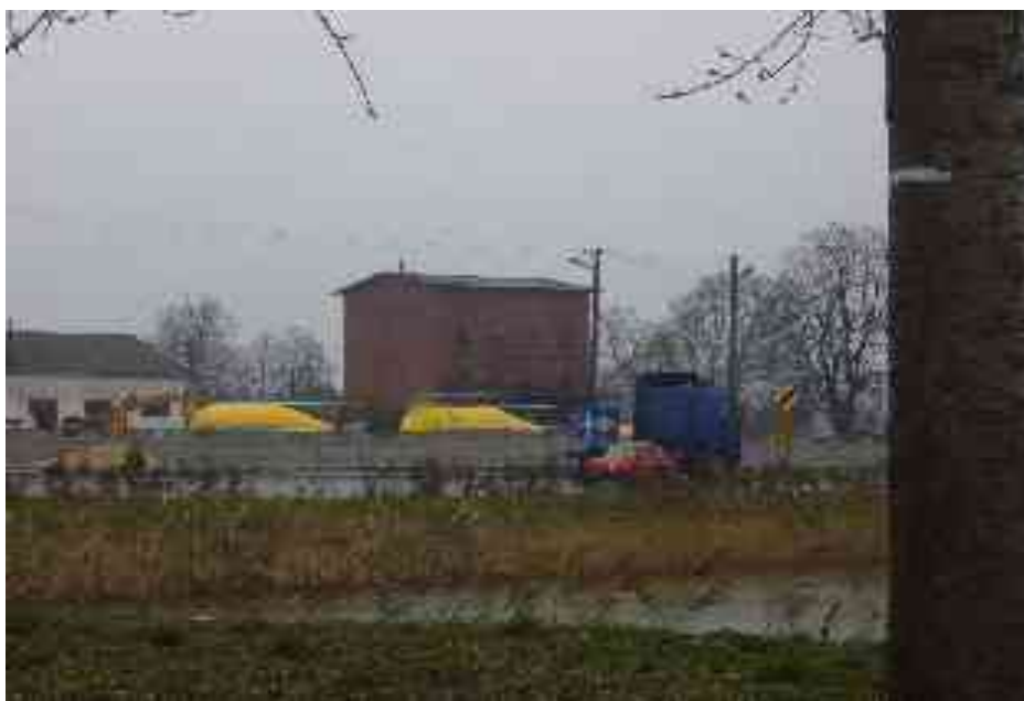
Zd. 2. Widok na spichlerz od strony ulicy.
