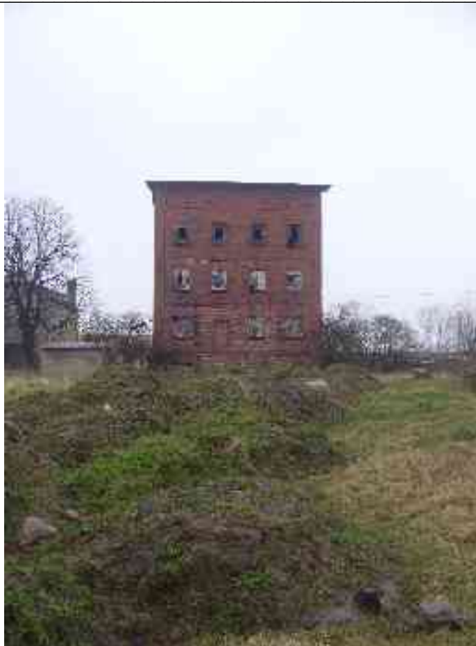
Zd. 1. Widok na budynek spichlerza.
